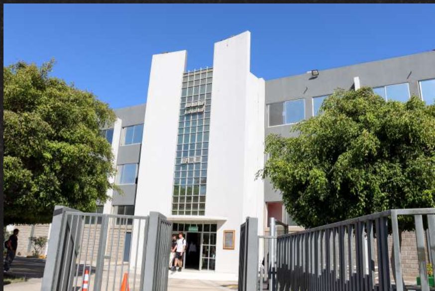
Edificio central FAE
